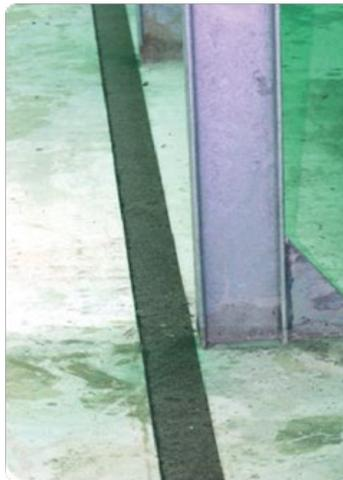
Figure 8 – Mise en place des bandes bitumeuses
