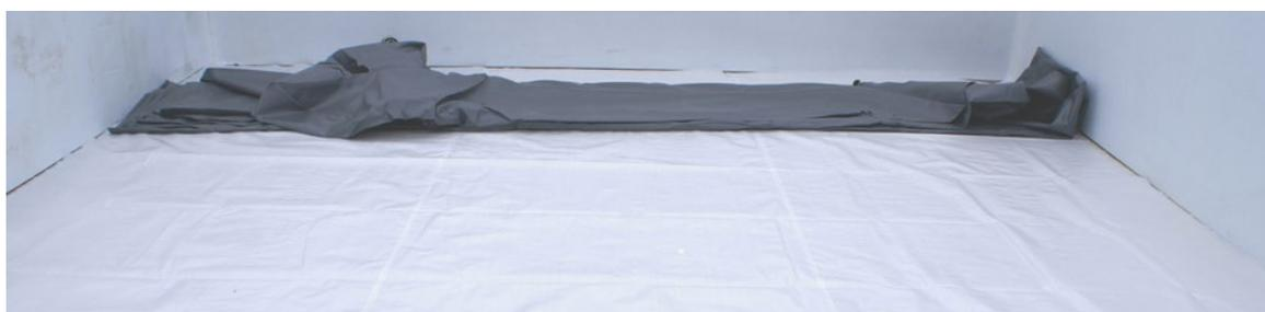
Figure 32 – Dépliage du liner
